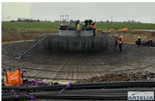
Montage de la cage d'ancrage et ferrillage
