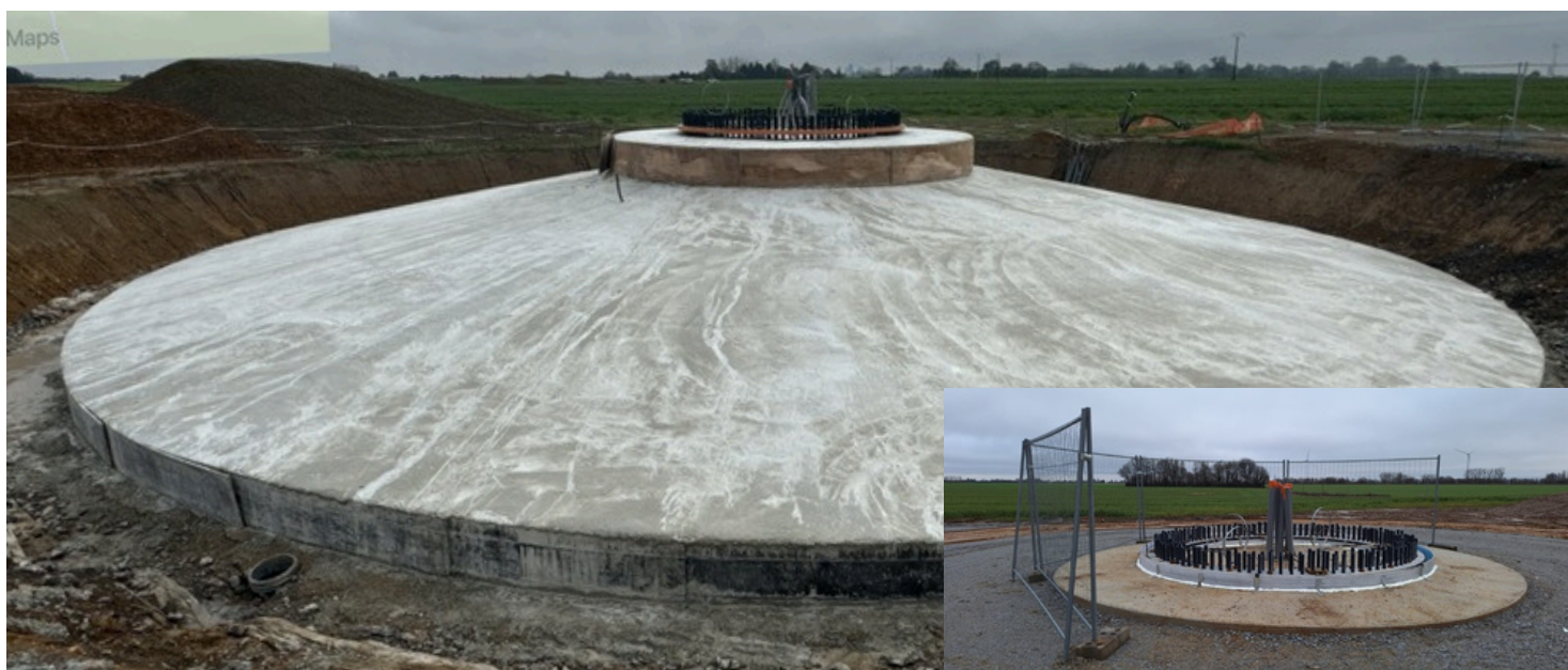
Fondation terminée, puis remblayée
