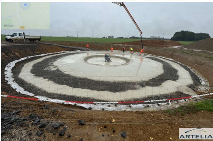
Réalisation du matelas de répartition
