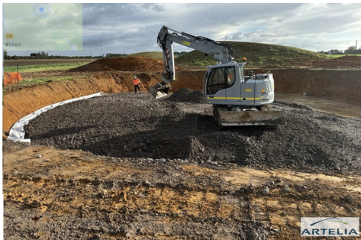
Excavation d'une future fondation
