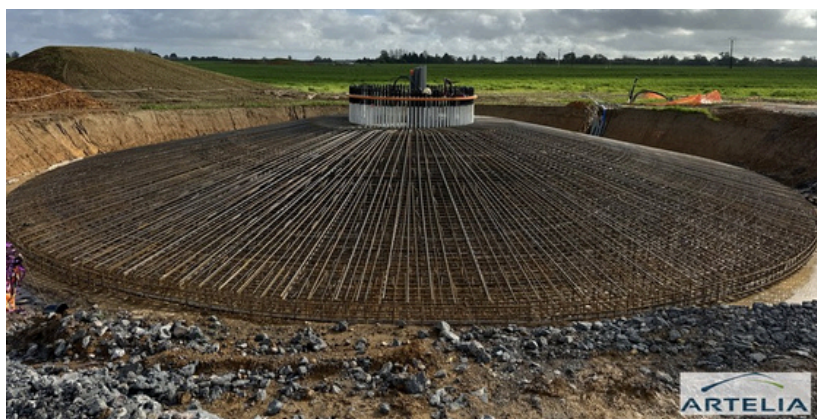
Montage de la cage d'ancrage et ferrillage
