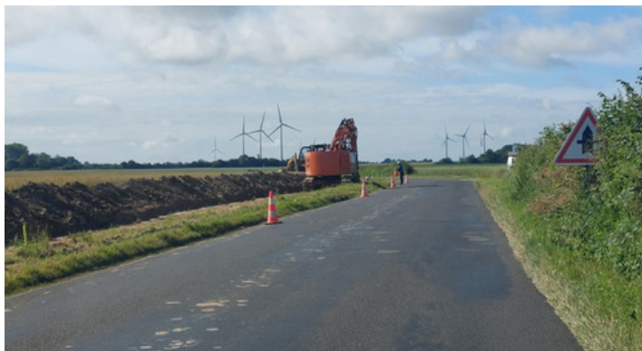
Pose des câbles électriques
